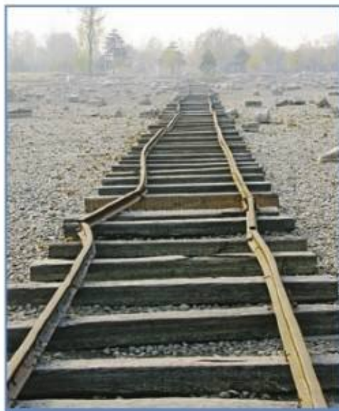
Деформация рельсов на железной дороге в результате землетрясения
