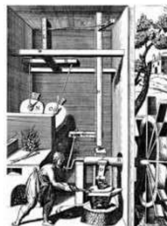
Кузница с водяным двигателем. Гравюра
