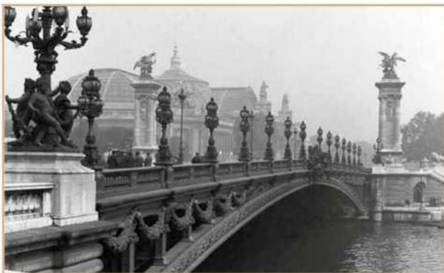
Мост Александра III в Париже. Фотография 1900 г.
