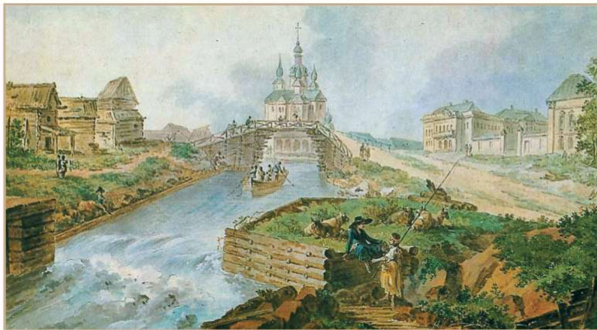
Вышний Волочёк. 1786 г. Художник Ж. Балтазар де ла Траверс
