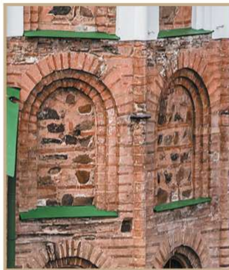
Софийский собор в Киеве. Кладка плинфы
