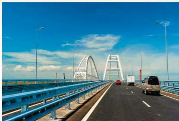
Мост через Керченский пролив
