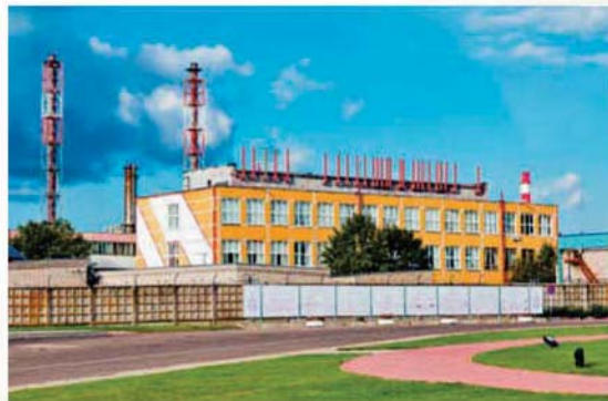
Дорогобуж. Завод по производству минеральных удобрений
