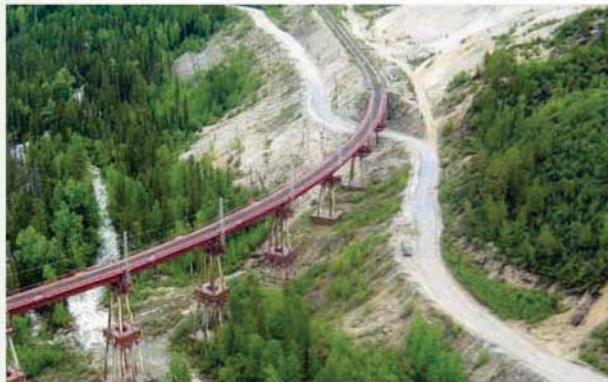
Чёртов мост — один из сложных участков БАМа. Построен на обходе Северо-Муйского тоннеля.
