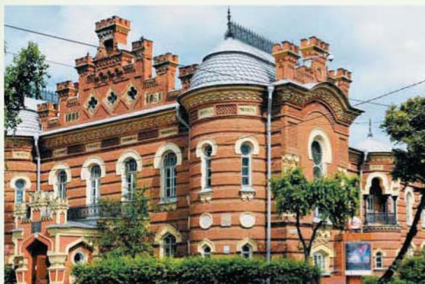
Иркутск. Краеведческий музей (здание было построено для Восточно-Сибирского филиала Русского географического общества)
