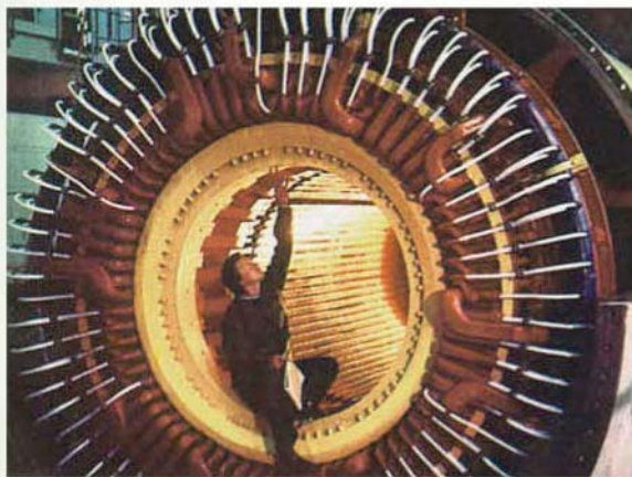
Сборка генератора на заводе «Электросила»
